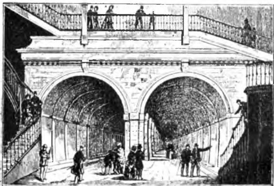
Вход в туннель, построенный Брюнелем.
